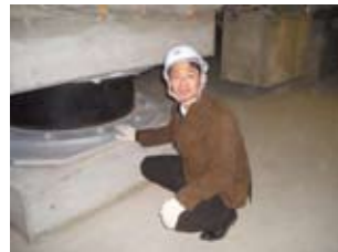
【愛知県庁舎耐震改修現場】
