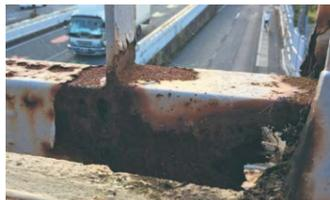
高欄の腐食が著しい横断歩道橋（国道1号）
