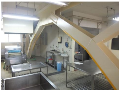
内部ブレース設置のイメージ
