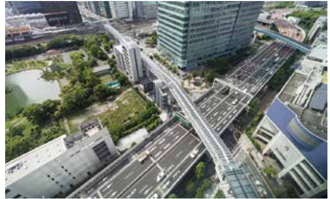
港歩行者専用道路8号線：賑わいを分断していた鉄道高架と首都高速道路高架上に歩行者動線を形成。
