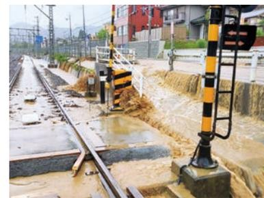
滋賀里12号踏切／道路側溝・菊の尾川から流入する土砂 【京阪電気鉄道株式会社提供】
